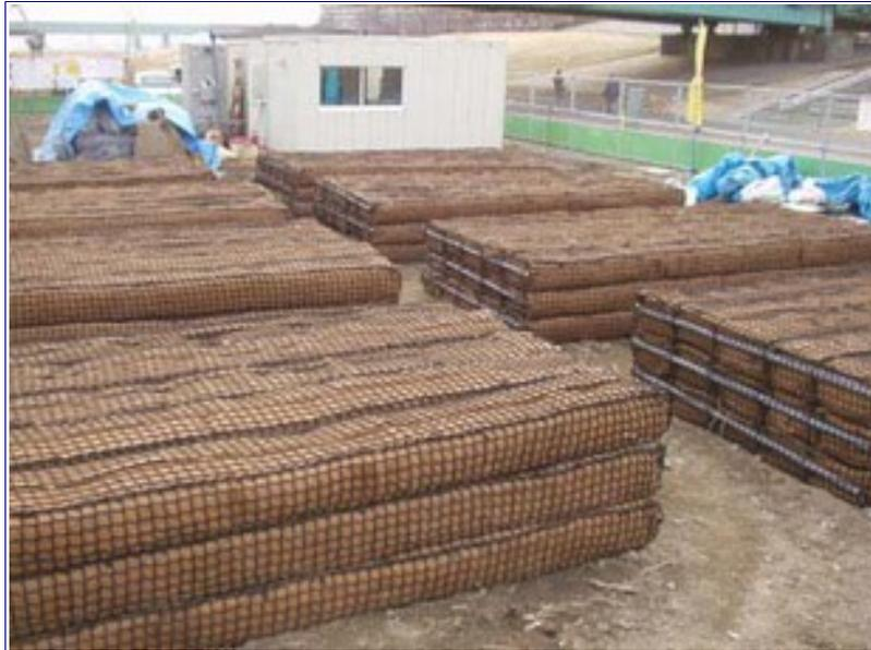
Successivamente alla realizzazione delle reti da impiegare come sistemi di rivestimento spondale viene eseguito un controllo di qualità molto dettagliato perché questi prodotti resistono fino a una velocità dell'acqua di 7 m/s.
